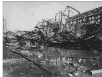
<破壊された工場>
